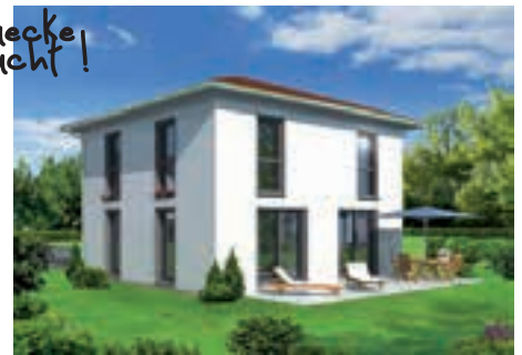
Einfamilienhäuser in KfW-70 & KfW-55 Bauweise
